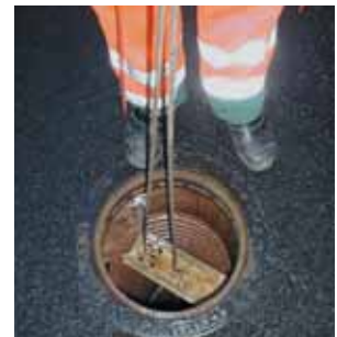
4 Rottespærren sænkes ned gennem opføringsrøret.
