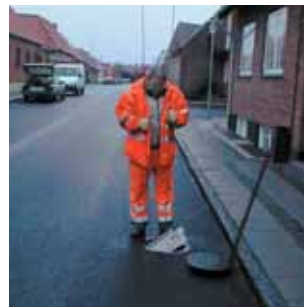
3 Rottespærren holdes i en vinkel på 45°. Pilen skal pege i løbsretningen.
