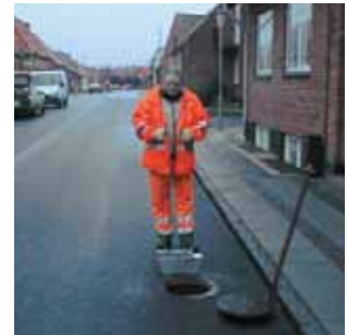
2 To rundjern monteres i bøjlerne på rottespærren.
